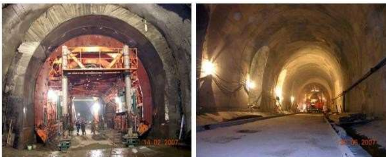
Рисунок 2.6 - Самоходная станция опалубки и постоянная обделка боковых стен тоннелей
